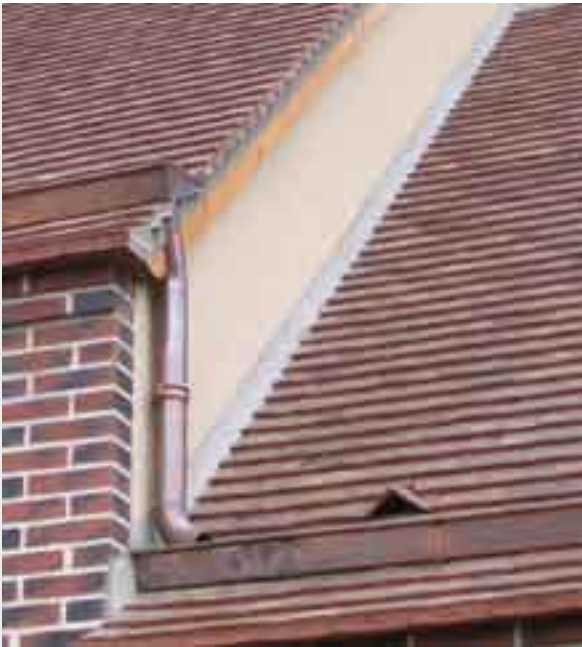
Détail d'une couverture neuve de type traditionnel.
