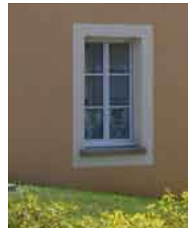
- Simply lissé et badigeonné de blanc, l'encadrement de cette fenêtre donne davantage de relief au mur et en éclaire la surface.
