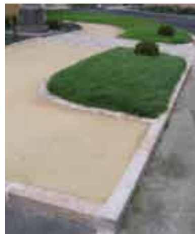
A gauche : Traitement hiérarchisé de la voirie et des espaces piétonniers traités en béton de sable associés à des passages piétons pavés.
