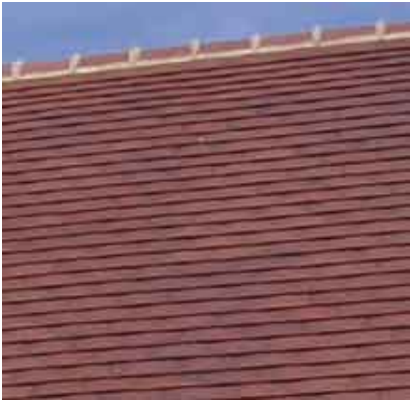
Couverture neuve aux teintes nuancées qui imite la tuile petit moule sans en avoir cependant la densité.
