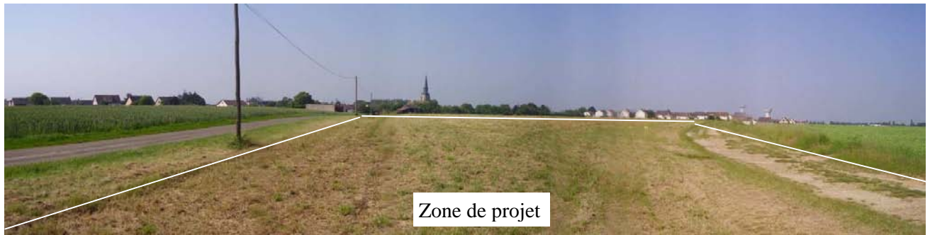
Photographie 2-1 : vue de la zone retenue pour le projet de lotissement
